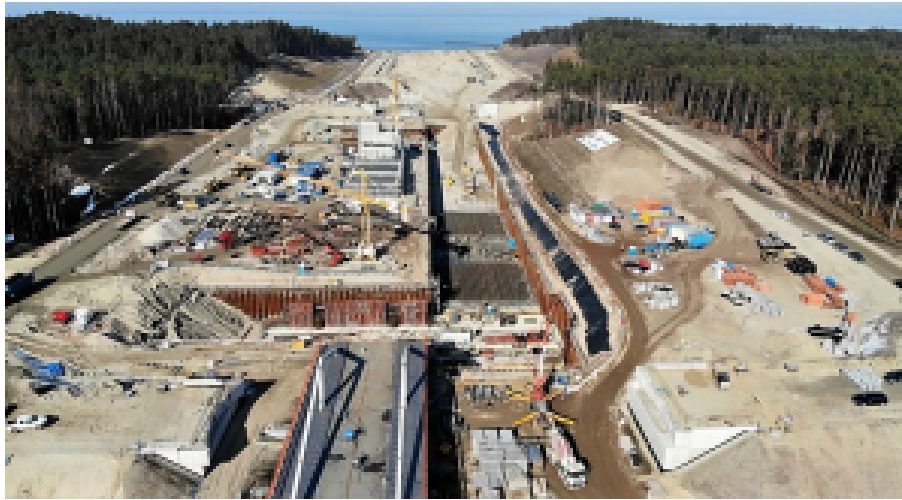
Kanalbaustelle im April 2021.
