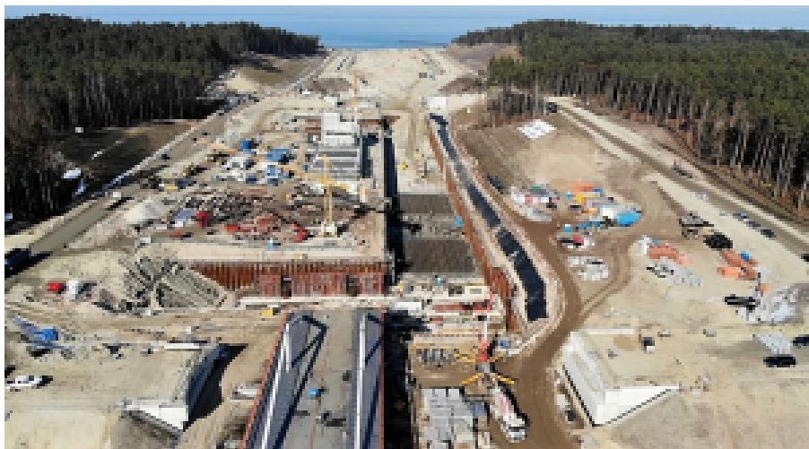
Kanalbaustelle im April 2021.
