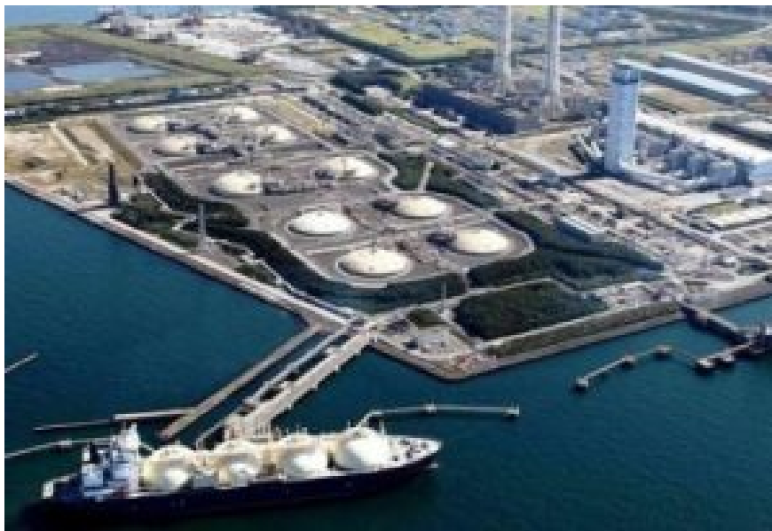
Flüssiggasterminal in Świnoujście.
