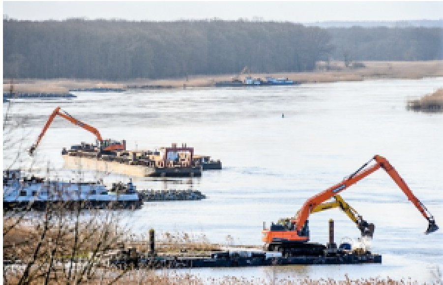
Bauarbeiten an der Oder im Frühjahr 2023
