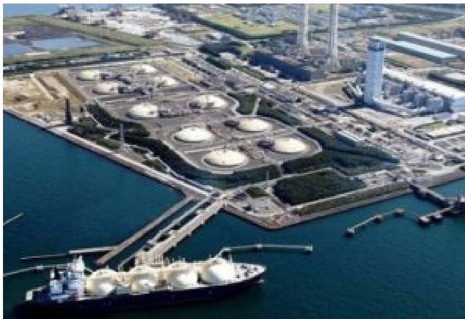
Flüssiggastterminal in Świnoujście/Swinemünde.
