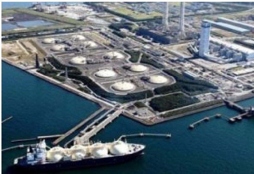
Flüssiggasterminal in Świnoujście.
