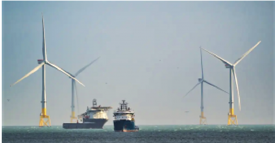
Bauarbeiten am Windpark in der Ostsee.
