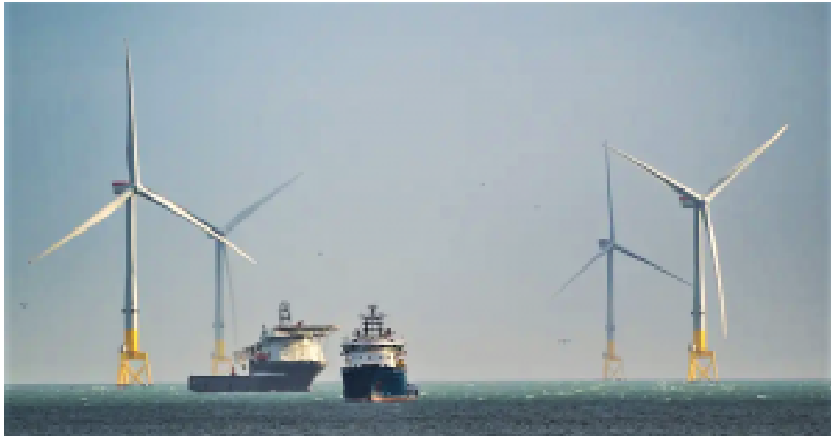
Bauarbeiten am Windpark in der Ostsee.
