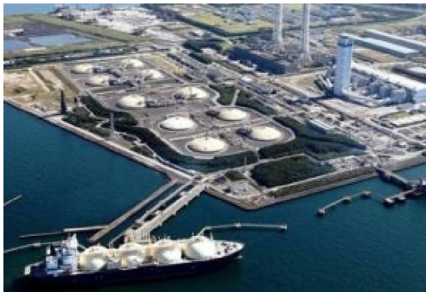
Flüssiggasterminal in Świnoujście.
