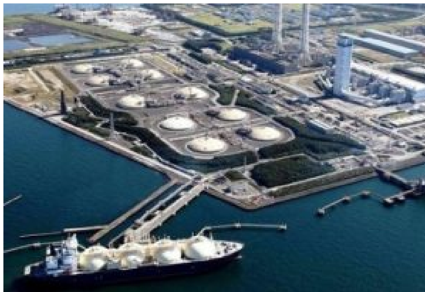
Flüssiggasterminal in Świnoujście.
