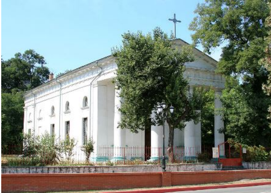
Wiederaufgebaute Kirche in Kertsch.
