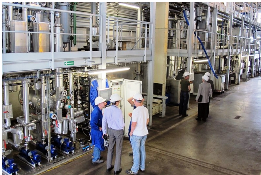
Forschungsanlagen des Instituts für Chemische Kohleverarbeitung (IChPW) im oberschlesischen Zabrze.
