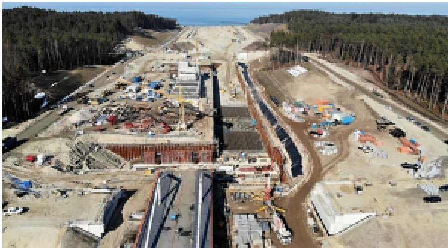
Kanalbaustelle im April 2021.
