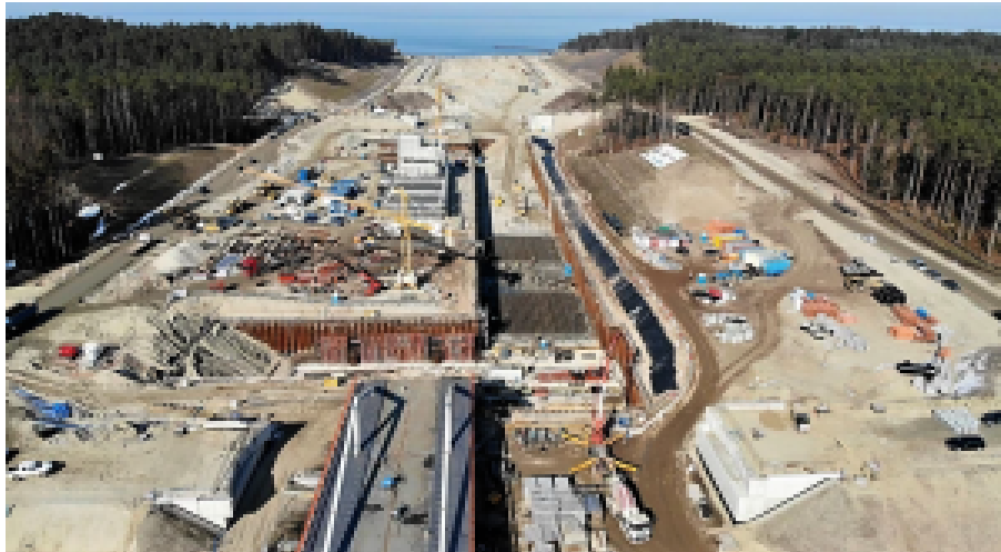
Kanalbaustelle im April 2021.
