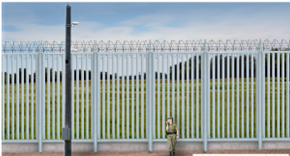
Geplanter Grenzzaun: 5,5 Meter hoch und mit einer Stacheldrahtkrone versehen, alle 5 Meter ein dicker Stahlpfahl, dazwischen 10 Zentimeter starke Stahlstaketen, modernste Überwachungsanlagen.
