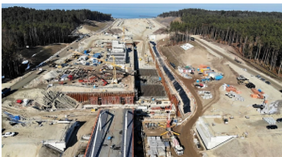
Kanalbaustelle im April 2021.
