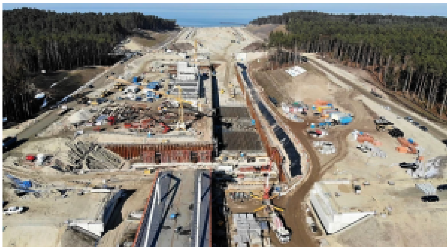
Kanalbaustelle im April 2021.
