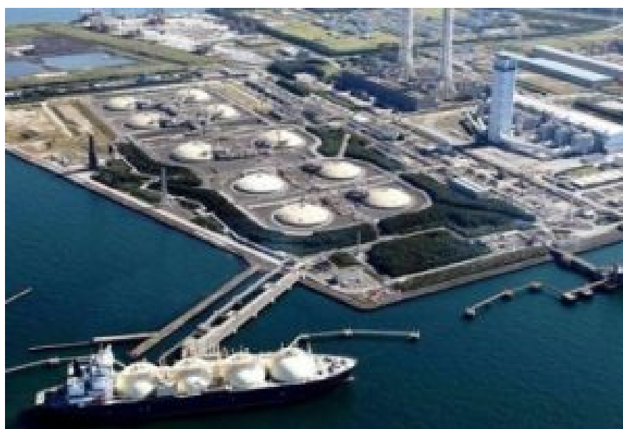
Flüssiggasterminal in Świnoujście.
