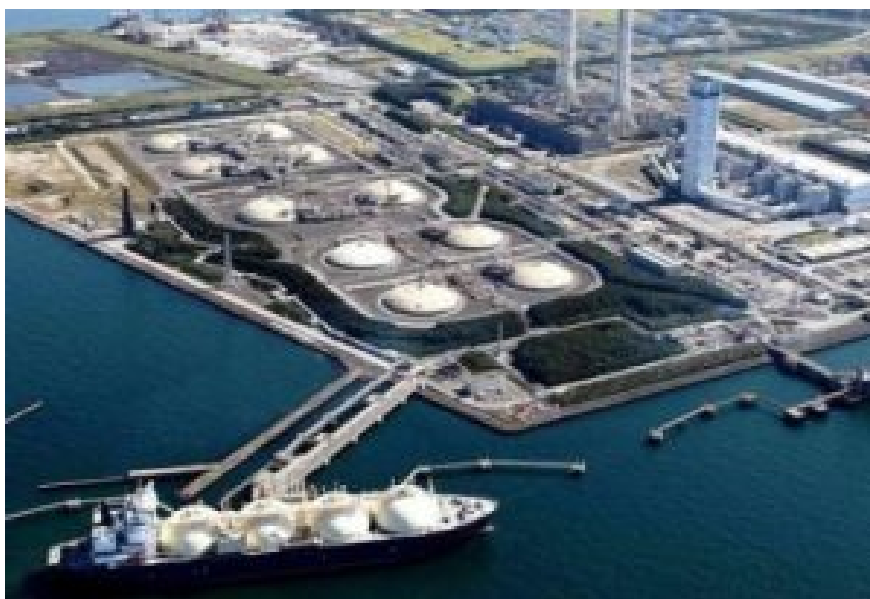
Flüssiggasterminal in Świnoujście.
