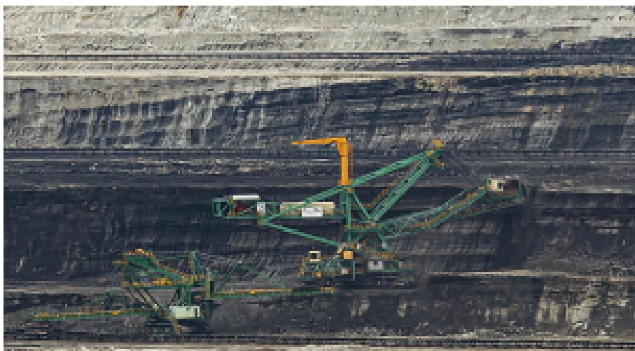
Das Kraftwerk und der Braunkohletagebau in Turów. Von hier kommen knapp 10 Prozent der polnischen Elektrizität
