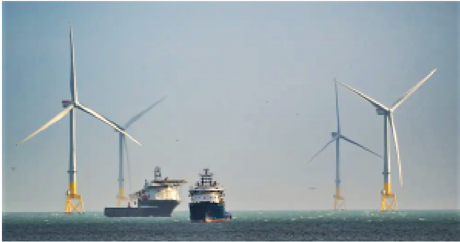
Bauarbeiten am Windpark in der Ostsee.
