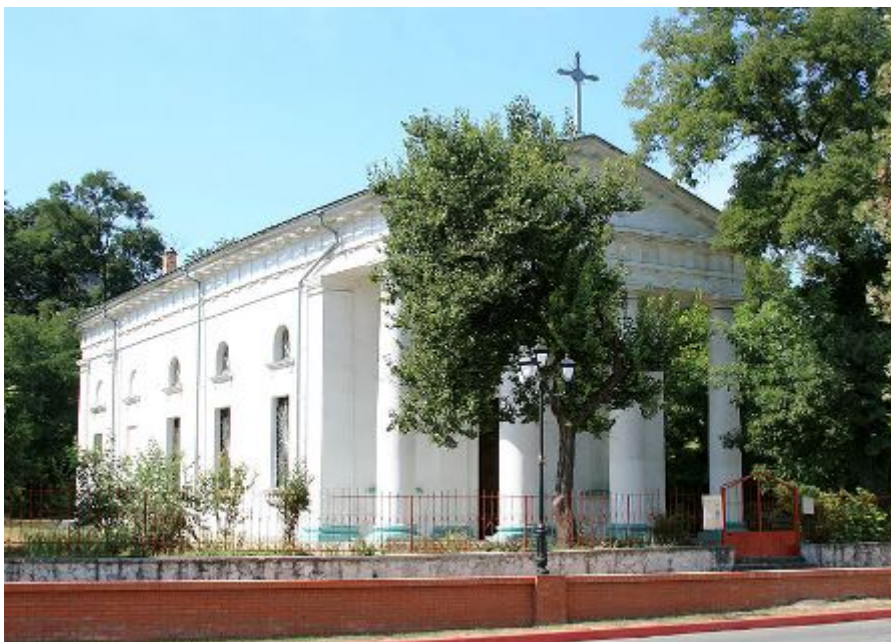
Wiederaufgebaute Kirche in Kertsch.
