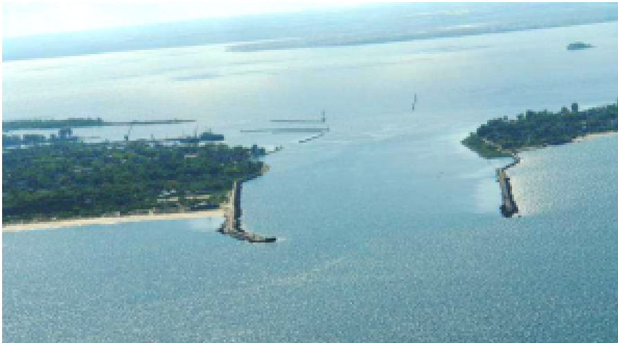
Pillauer Seetief. Luftaufnahme.
