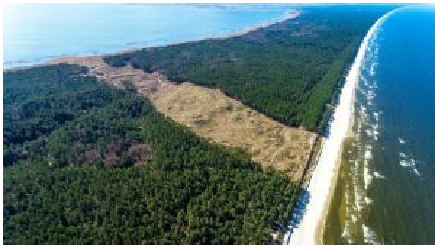
Kanaltrasse ohne Bäume.
