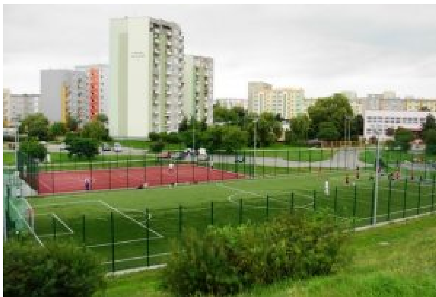
Eine typische Orlik-Sportanlage, hier in Bydgoszcz. Fußballplatz (vorne) 30 m x 62 m mit künstlichem Rasen. Dahinter ein Mehrzweck-Sportplatz 20 m x 30 m mit Tartan-Bodenbelag für Handball, Basketball, Volleyball. Dazu gehört eine Umkleidekabine mit Sanitäranlagen von ca. 60 qm. Kosten umgerechnet ca. 250.000 Euro.
