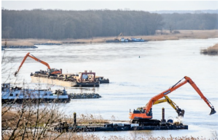
Bauarbeiten an der Oder im Frühjahr 2023
